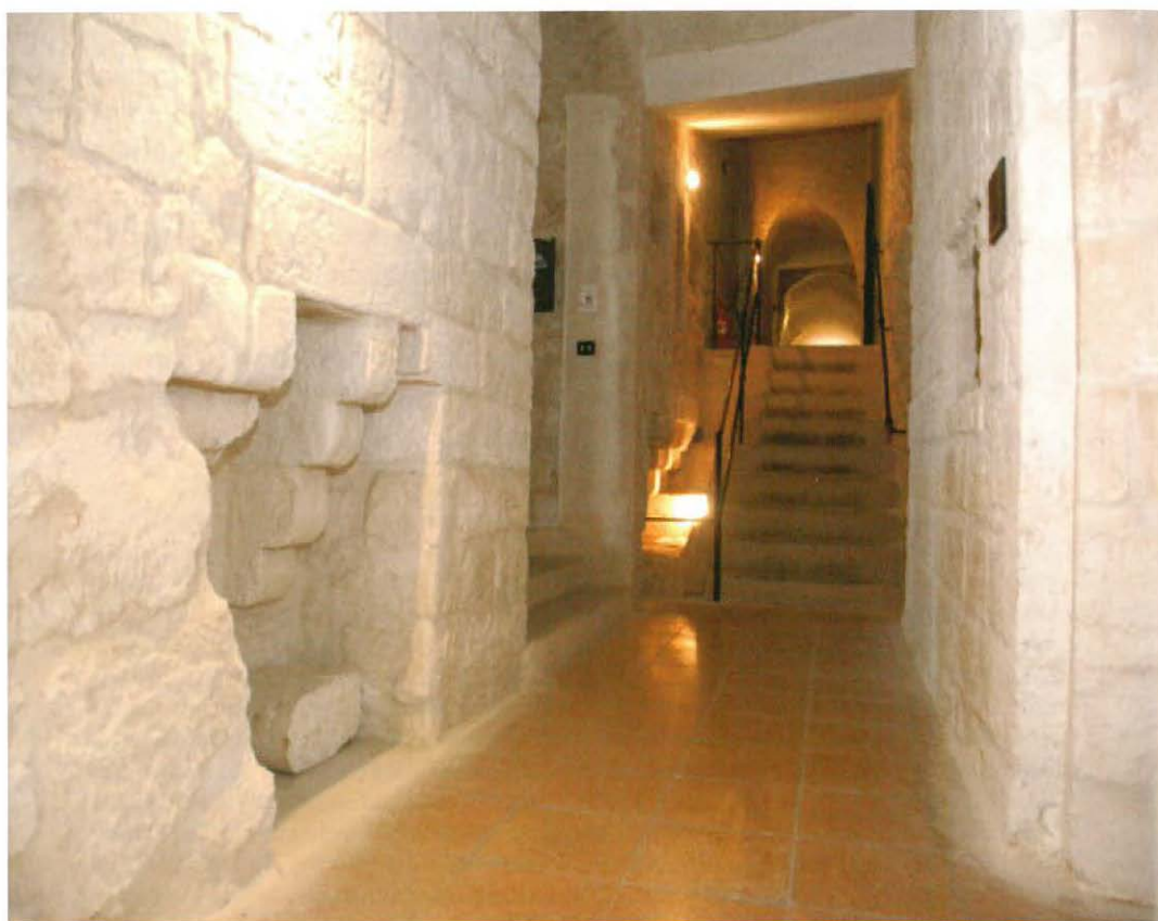
Fig. 38 Corridoio di Levante. Sulla sinistra sono visibili il lato di ponente del Muro di Crispano e l'interruzione dell'apparato aggettante.
