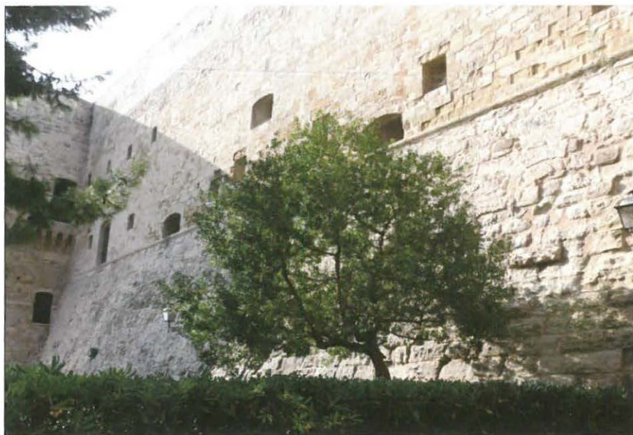
Fig. 30 Facciata di levante del Muro di Crispano.
